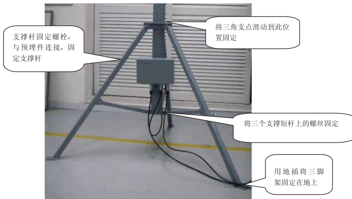
图1安装三角支架
